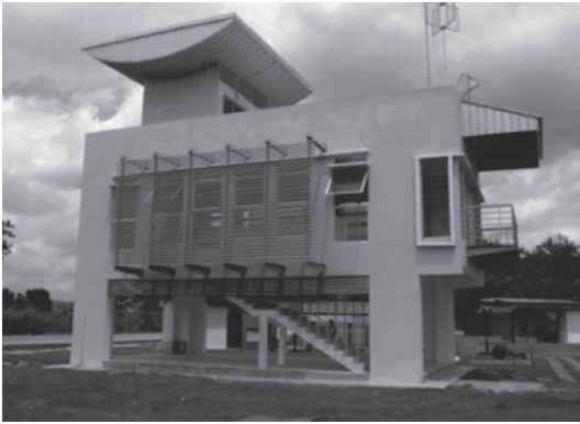
Figura 13. Fotografía de una casa experimental con techo Venturi en forma de ala de avión invertida. Tomada de Chin (2012).
